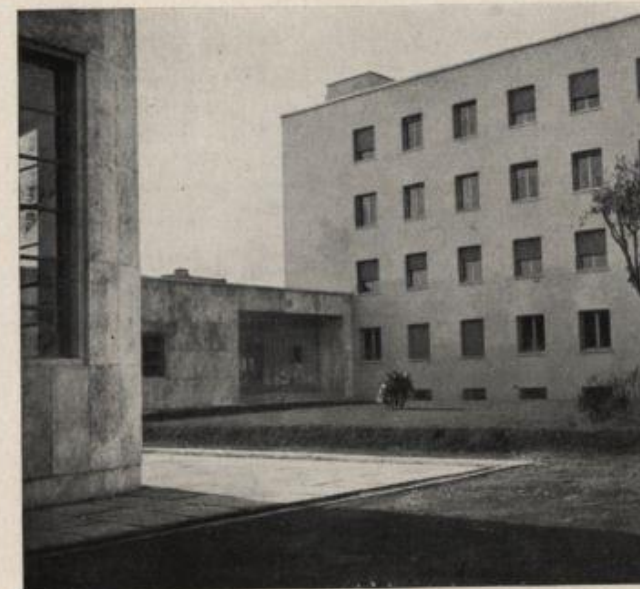
IL CORTILE TRA IL RISTORANTE E I BLOCCHI D'ABITAZIONE.
