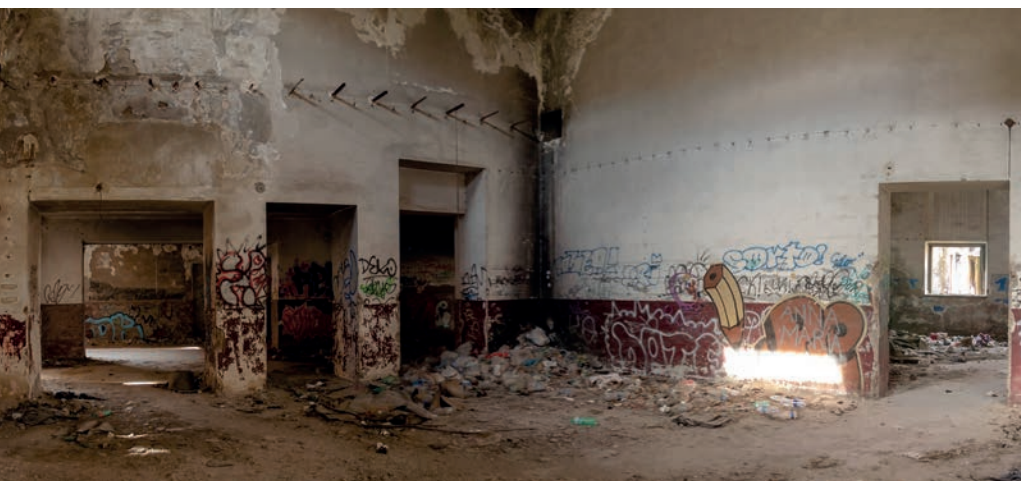
fig. 88 Sopralluogo: locale a doppia altezza favorisce l'ingresso di molta luce
