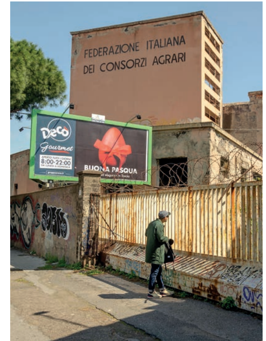
fig. 59 Ingresso dell'ex-opificio della Federconsorzi
