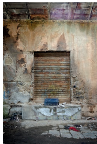
fig. 85 Uno dei portali del capannone a sud
