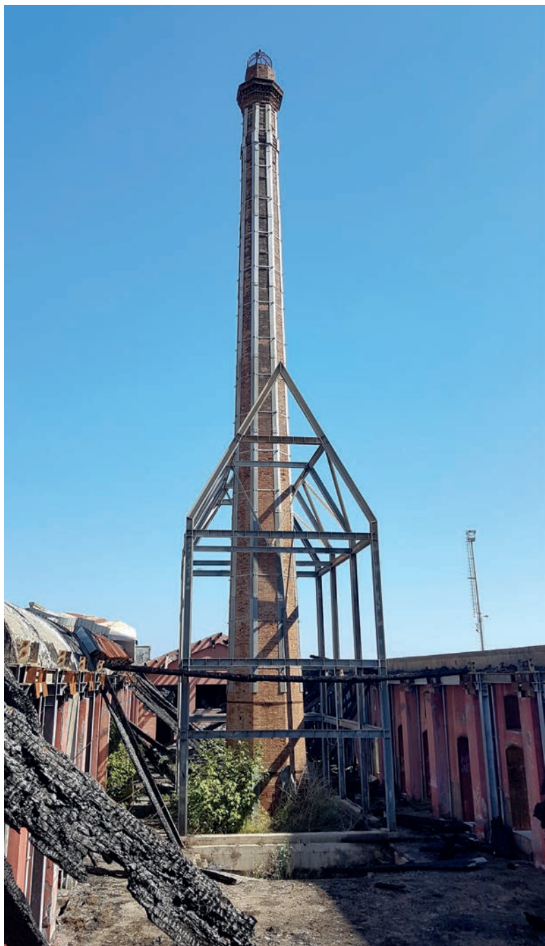
fig. 74 Sopralluogo: vista della ciminiera e della struttura realizzata negli anni 2000
