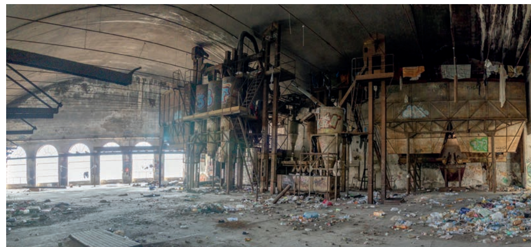
fig. 89 Sopralluogo: il capannone a sud contiene macchinari originali caratteristici
