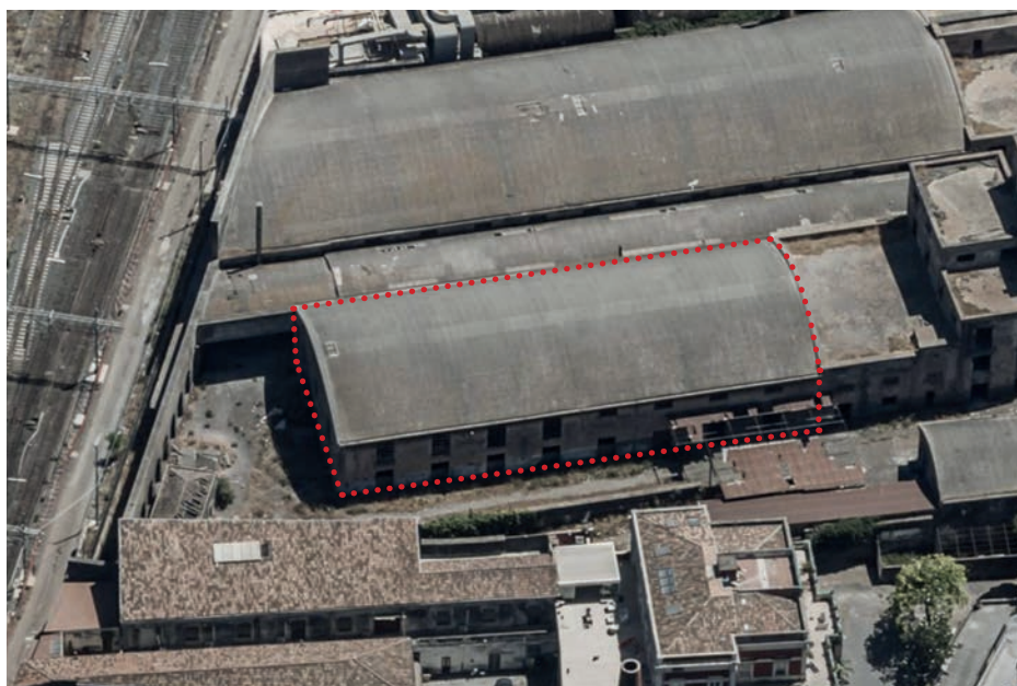
fig. 101 Vista dall'alto del blocco B
