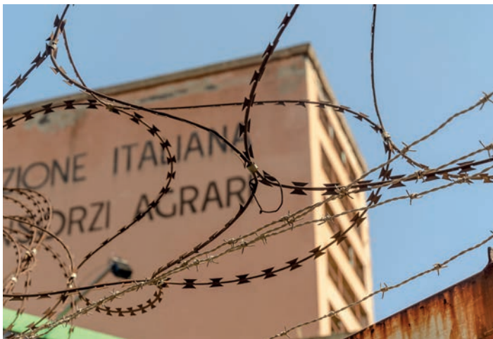
fig. 81 Sopralluogo: vista dalla strada della torretta realizzata successivamente
