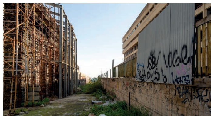
fig. 78 Sopralluogo: Il corridoio d'ingresso. A sinistra la sala di sublimazione
