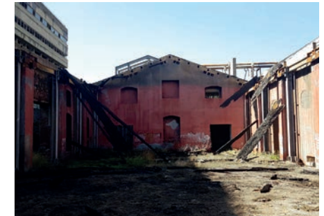
fig. 119 Vista della corte in direzione della strada
