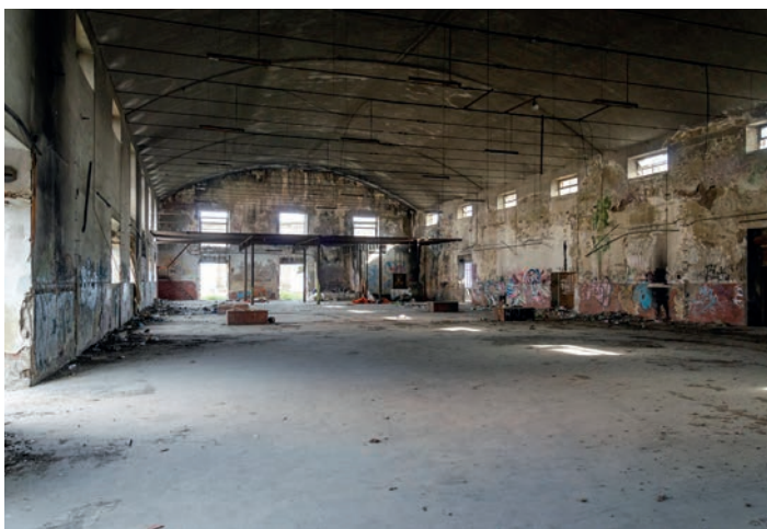
fig. 82 Sopralluogo: il capannone più a nord.
