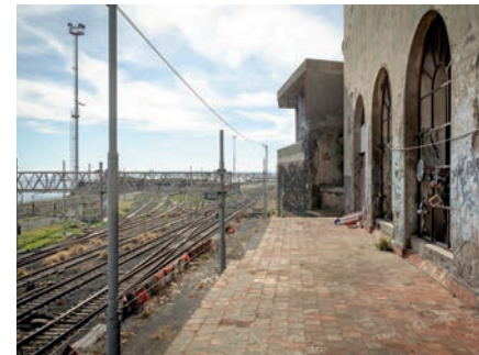
fig. 113 piano in aggetto sulla ferrovia
