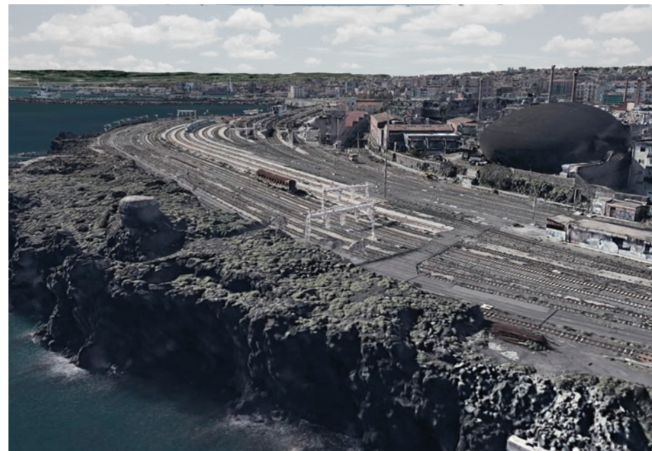
fig. 32 Vista 2: rete ferroviaria e struttura ovoidale del complesso "Le Ciminiere"
