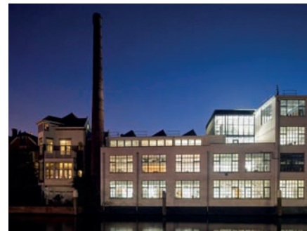
fig. 20 Vista dall'esterno sulla ciminiera.
