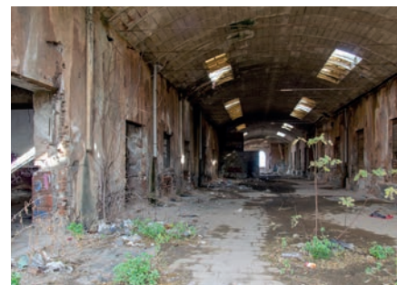
fig. 97 Vista del blocco (a sx) dalla galleria centrale
