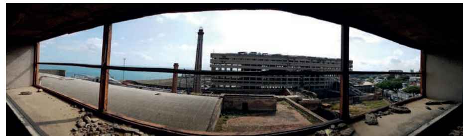
fig. 100 Vista dall'ultimo piano della "torretta d'uffici"
