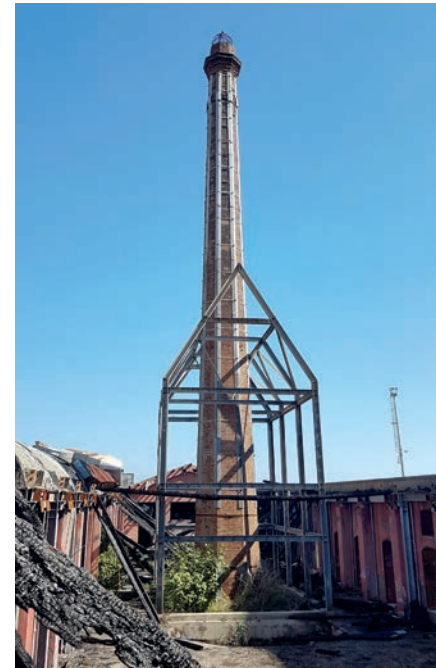
fig. 117 Vista della ciminiera dal blocco 2
