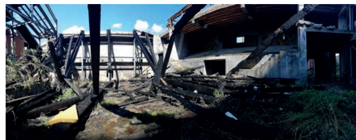
fig. 77 Sopralluogo: quella che doveva essere la sala convegni
