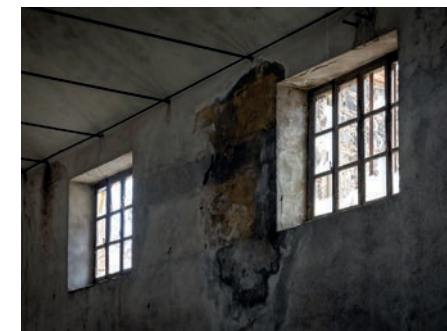
fig. 110 Vista delle grandi aperture a sud
