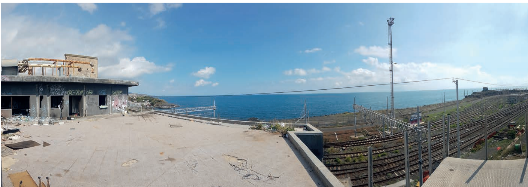
fig. 73 Sopralluogo: vista dalla terrazza dell'ultimo piano verso il mare.
