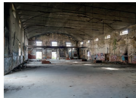
fig. 102 Vista provenendo dal blocco A
