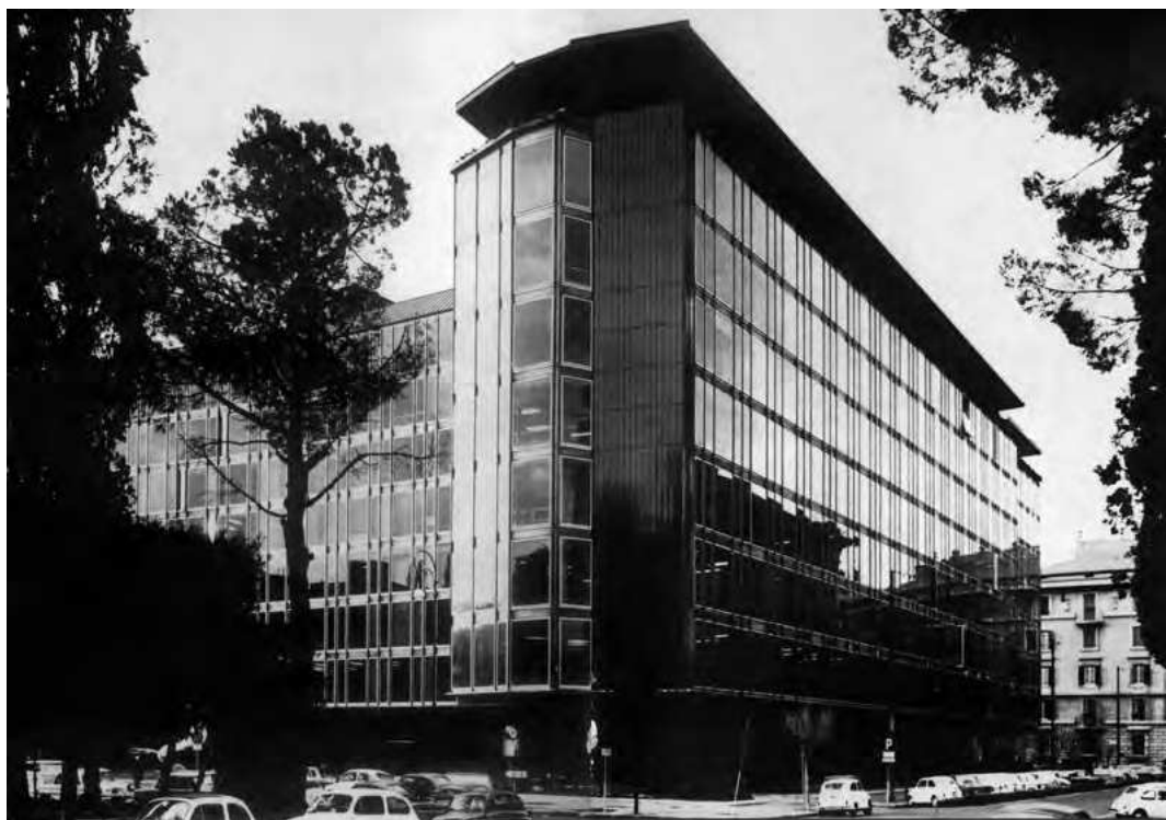
Fig. 6 - Vista del Centro Direzionale Rai da Viale Mazzini: la scansione ritmica del curtain wall e le soluzioni d'angolo (fonte: L'architettura Cronache e storia n. 142)
