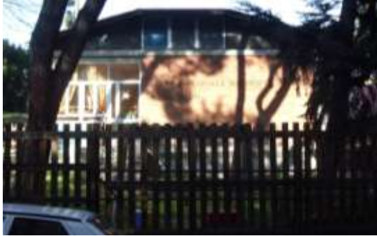
prospetto est su via Rocco da Cesinale
