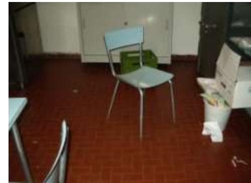
pavimento nel piano terra
