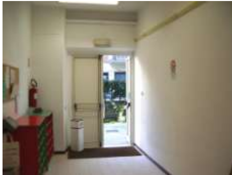
uscita di sicurezza piano terra
