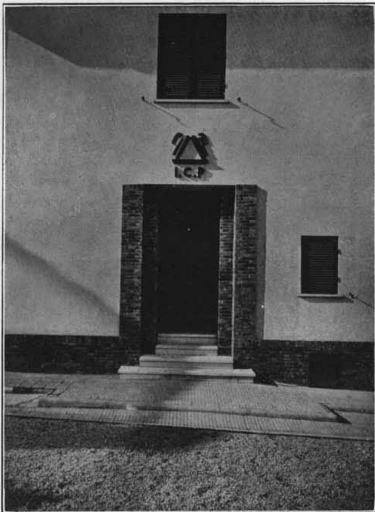
ARCH. GINO CANCELLOTTI: DETTAGLIO DI UN INGRESSO DEL FABBRICATO N. 7.
