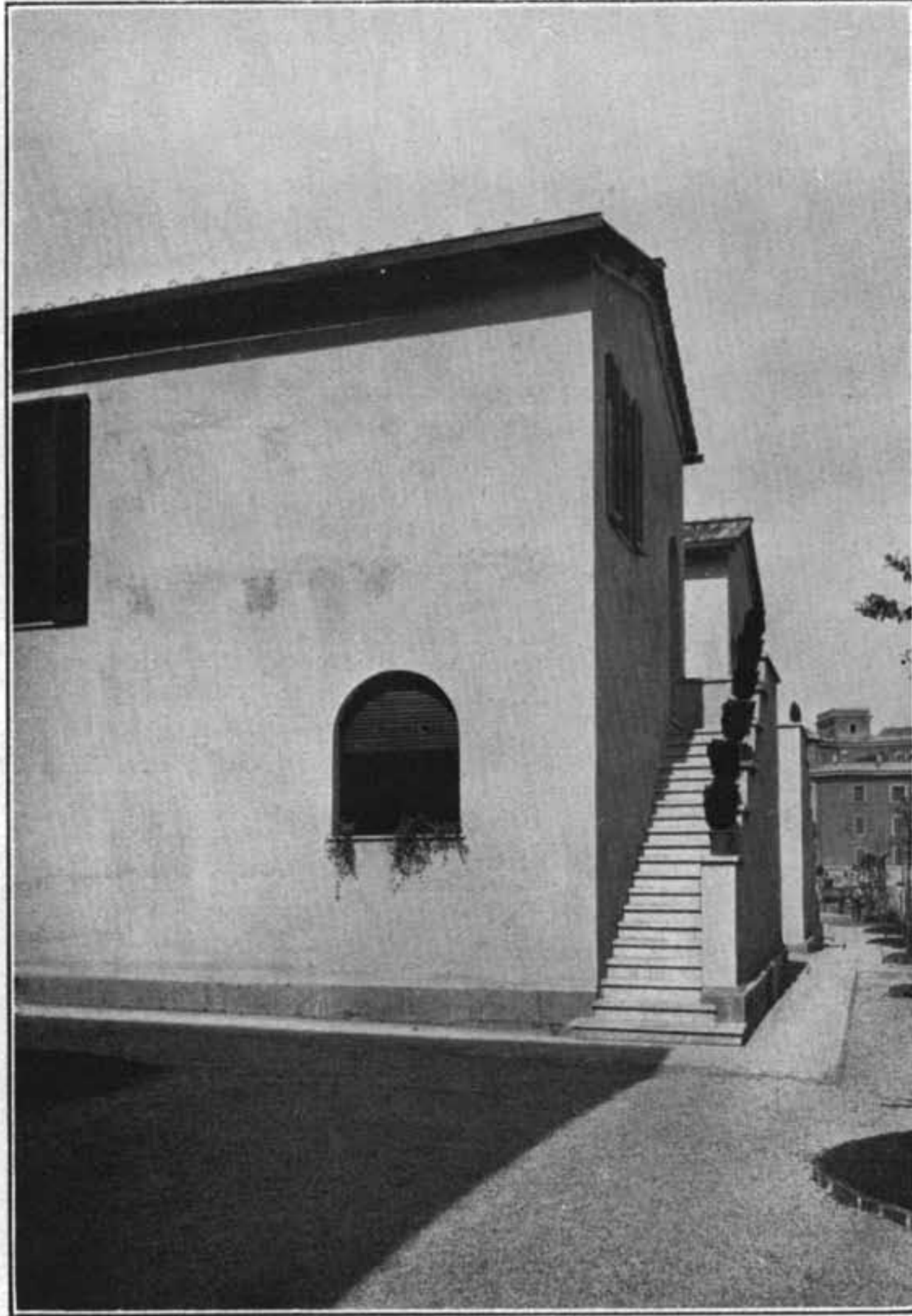
ARCH. VIETTI LUIGI: FABBRICATO N. 12 - SCORCIO.
