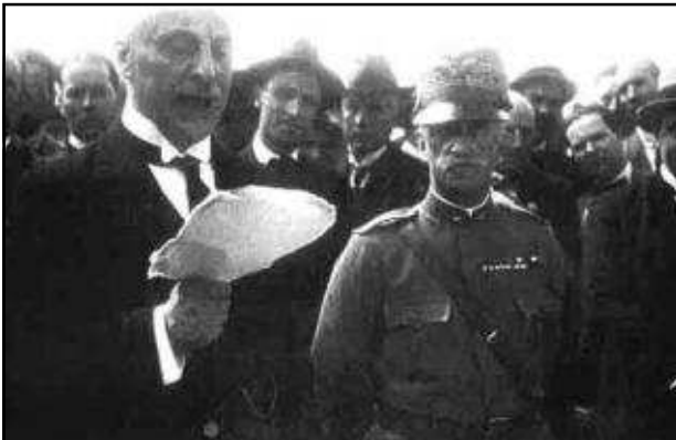
Paolo Orlando e il re Vittorio Emanuele III alla posa della prima pietra del nuovo porto di Ostia Nuova . febbraio 1920
