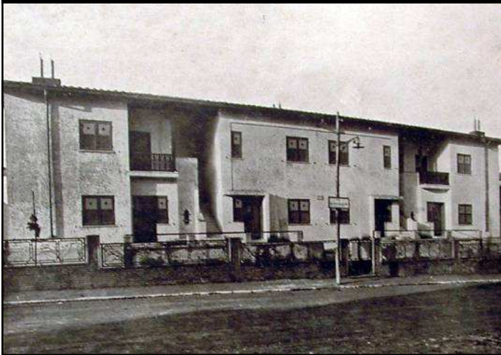
9. Pietro Aschieri schiera composta da quattro alloggi sovrapposti a divisione orizzontale e due a divisione verticale
