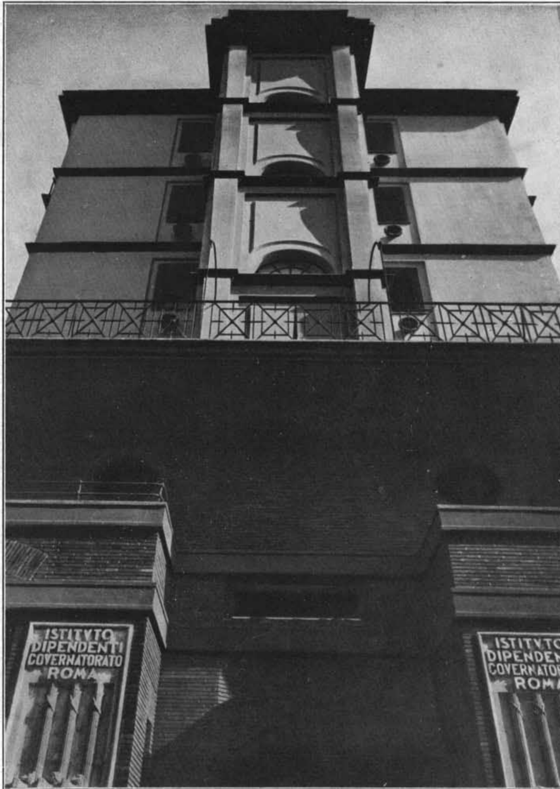
FIG. 8. - ARCH. MARIO DE RENZI E LUIGI CIARROCCI: CASA D'ABITAZIONE IN VIA ANDREA DORIA A ROMA. - PARTICOLARE DELLA TESTATA DEL SECONDO CORPO DI FABBRICA.
