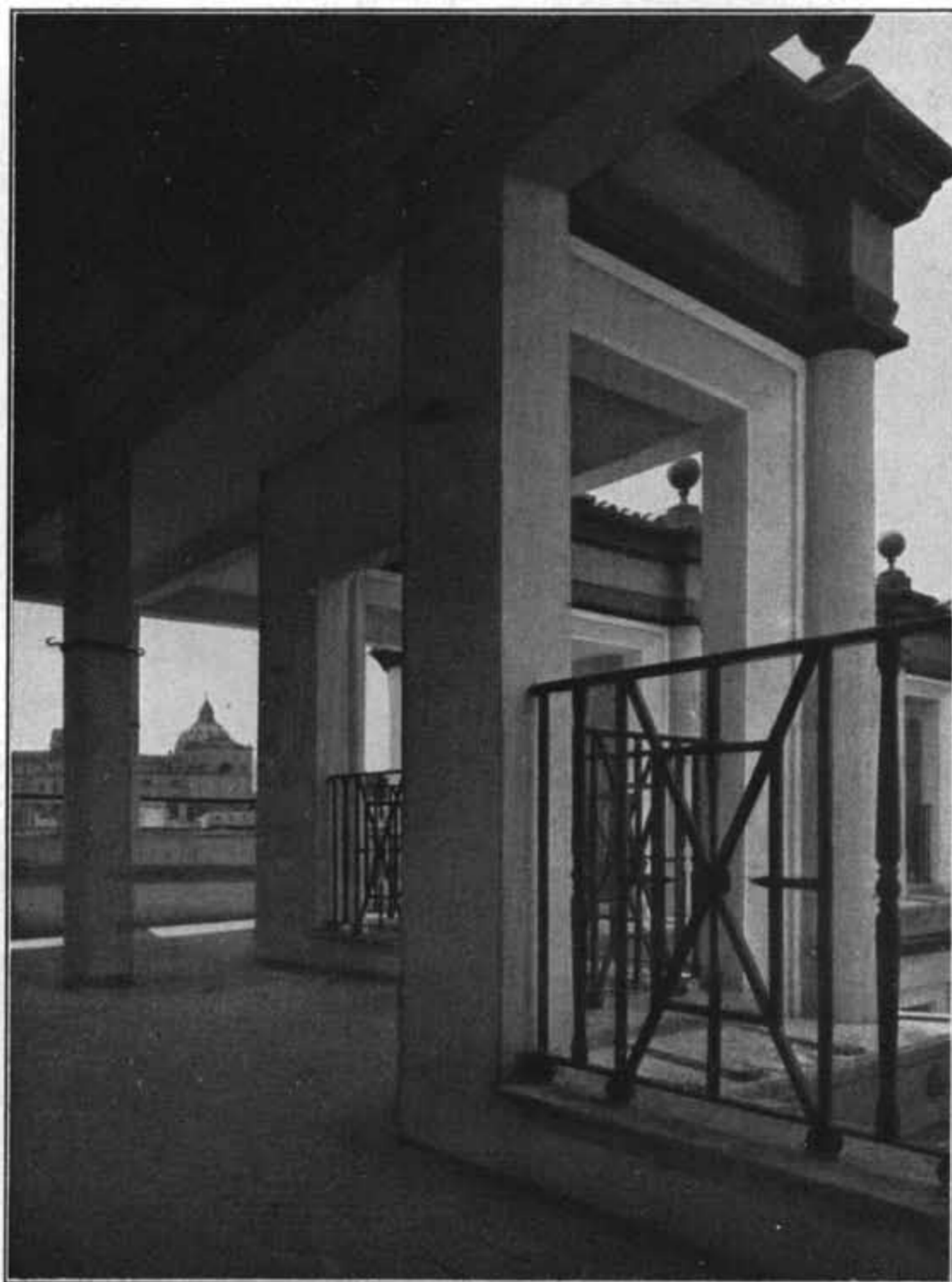
FIG. 13. - ARCH. MARIO DE RENZI E LUIGI CIARROCCHI. CASA D'ABITAZIONE IN VIA ANDREA DORIA A ROMA. STENDITOIO COPERTO VISTO DAL LATO SUD.
