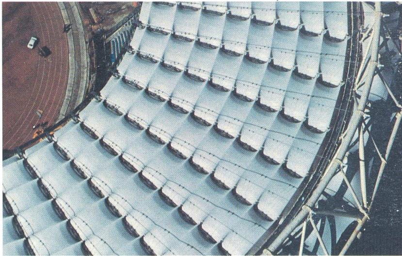
Fig. 8.61 Vista aerea di una zona della copertura dello Stadio Olimpico dove si possono notare i vari elementi costitutivi del sistema costruttivo: l'anello esterno reticolare, le tensostrutture radiali, l'anello interno in funi ed i moduli di copertura in Teflon.
