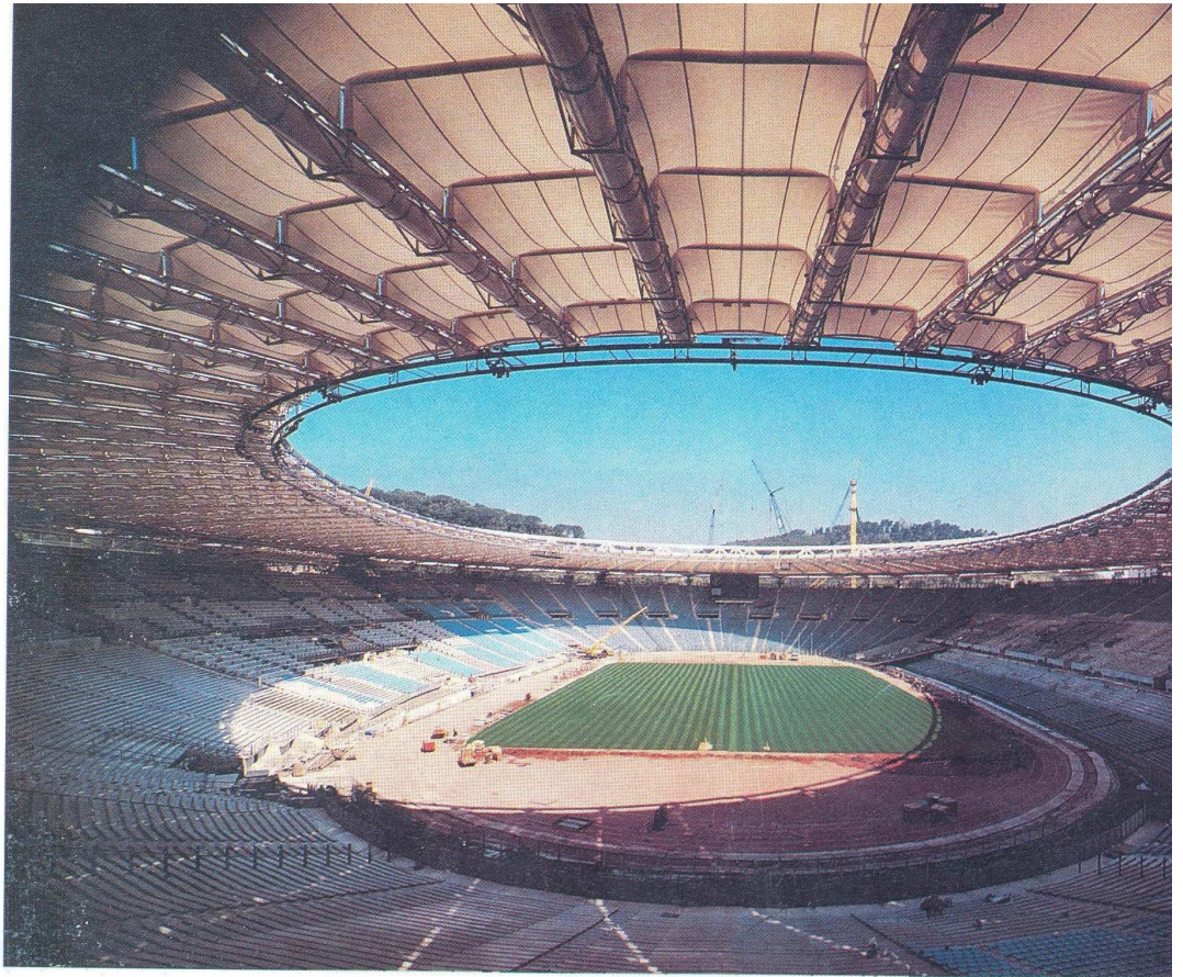
Fig. 8.64 Vista interna dello Stadio Olimpico, Roma.
