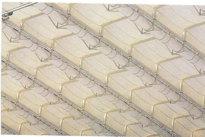
Fig. 8.66 Dettaglio della copertura dall'interno
