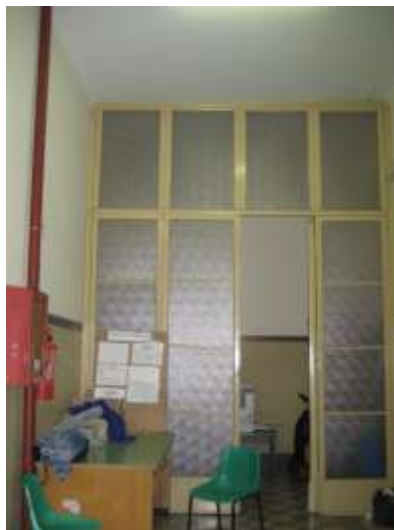
Oltre la vetrata la nuova parete di separazione dalla Biblioteca Comunale
