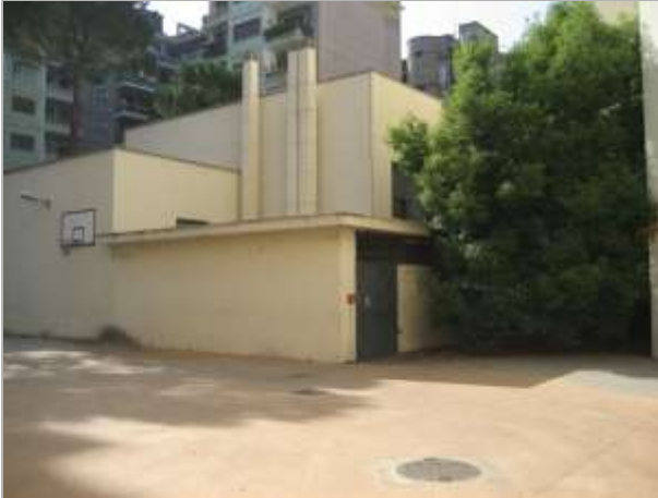
La centrale termica addossata alla palestra
